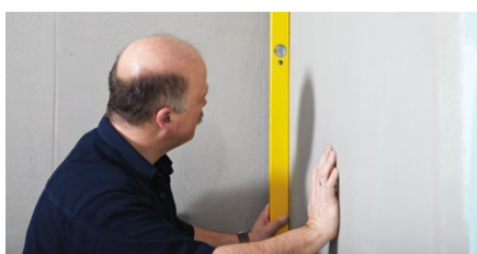
1. Prüfen der Montagewand
