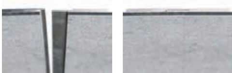
Plattenstoßprofil geöffnet Plattenstoßprofil geschlossen
