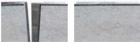
Plattenstoßprofil, geöffnet Plattenstoßprofil, geschlossen
