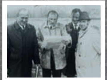
Grundsteinlegung für den heutigen Standort von Gebrüder Schulte im Dümpel 22
