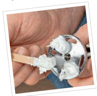
**3b** ... Kleber aus unserem Set „Einfach Kleben“-System anrühren und Montageplatte ankleben. Nach ca. 5 Stunden kann das Gestänge aufgesteckt und mittels Gewindestift befestigt werden. Waagerechte Stange befestigen und Kopfbrause und Handbrause aufschrauben. FERTIG!
